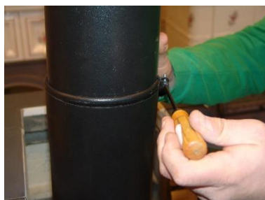
8- Finaliser le serrage du tuyau coulissant
