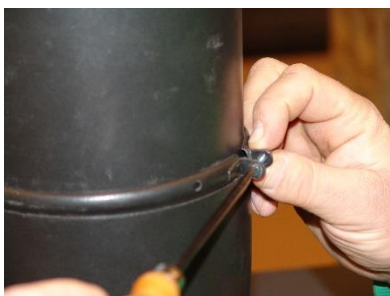
1- Desserrer le cerclage du tuyau coulissant du conduit
