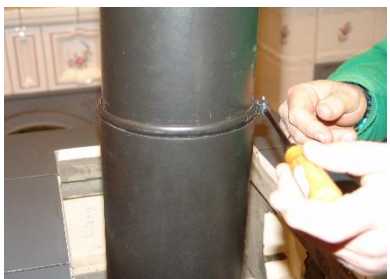
4- Stabiliser ensuite le tuyau coulissant, le temps du ramonage
