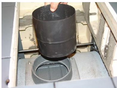
2- Retirer le tuyau de 15cm muni du catalyseur
