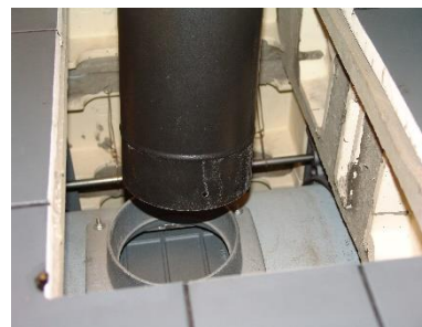
3- Remettre en place le tuyau coulissant
